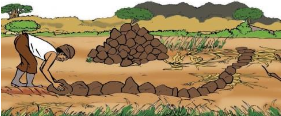
Mise en place d'un cordon pierreux
