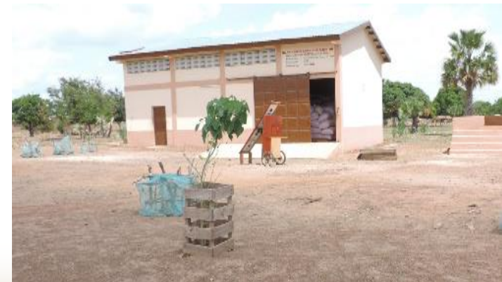
Construction de Magasins de stockage
